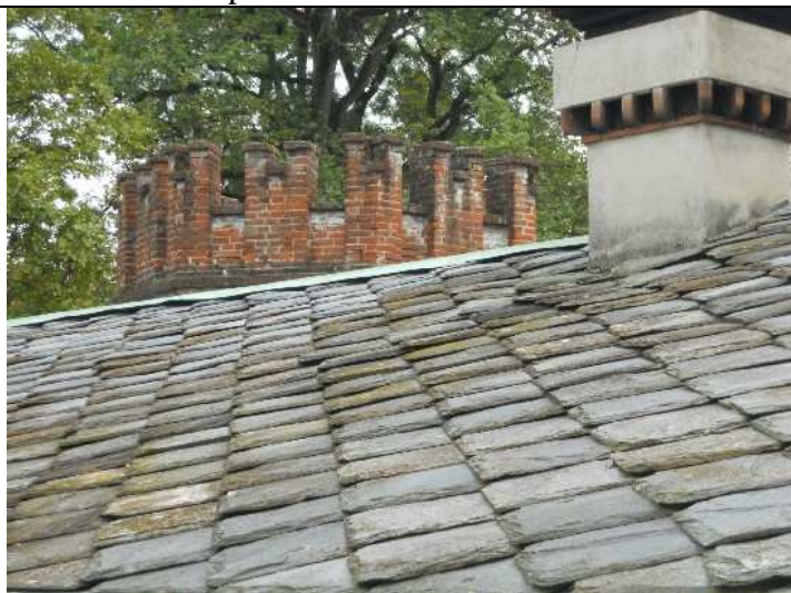
Foto nr. 4 : Particolare del degrado dei camini.
