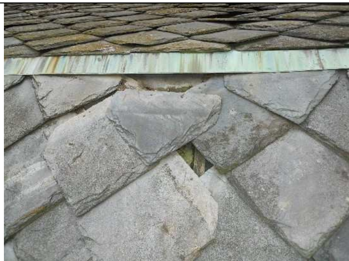
Foto nr. 3: Dettaglio della faldaleria da sostituire
