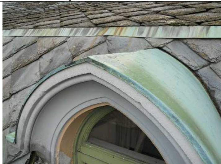
Foto nr. 5: Dettaglio della faldaleria da sostituire
